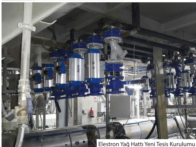
Pulver 3 Yollu Vana Montajı
